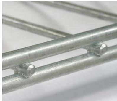
Bester Korrosionsschutz der **RANKO** Doppelstabmatten dank Stückverzinkung im Vollbad!
